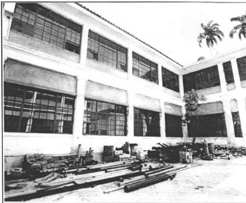
Renovation and conditioning of the Ancón facility to house the STRI Center of Paleoeecology and Archaeology is expected to be completed by the beginning of December. The photo shows the already installed glass windows for the Center's offices and laboratories ••• La remodelación y acondicionamiento del edificio de Ancón donde operarán los miembros del Centro de Paleoeecología y Arqueología de STRI se espera completar para principios de diciembre. En la foto se pueden apreciar todas las ventanas de vidrio recién instaladas, para las oficinas y laboratorios del Centro. Foto: M.A. Guerra
