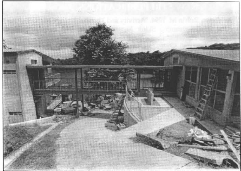
This photo, taken on Sep 30, shows the bridge connecting the north (left) and south wings of the new laboratory building on BCI. Completion of all new facilities on BCI is expected by the end of the year ••• En la foto, del 30 de septiembre, se aprecia el puente que conecta las alas norte (izq.) y sur del nuevo edificio para laboratorios en BCI. Para final de año se espera que todas las nuevas instalaciones en Barro Colorado sean entregadas. (Foto: A. Montaner
