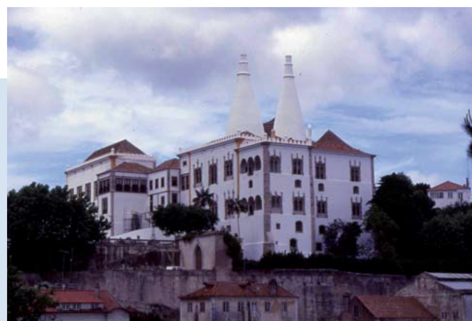
EL PALACIO DE SINTRA LUEGO DE LA INTERVENCIÓN (1997). ESTA FUE REALIZADA USANDO MORTEROS DE CAL ÁREA, COMPATIBLES CON EL MORTERO HISTÓRICO. SÓLO SE INTERVINERON ÁREAS QUE MOSTRABAN UN DETERIORO ACTIVO, COMO EVIDENCIADO EN LA FOTO ANTERIOR. SE APLICÓ LUEGO UNA LECHADA DE CAL, QUE ACTÚA TAMBIÉN COMO DESINFECTANTE ELIMINANDO LA COLONIZACIÓN BIOLÓGICA.
