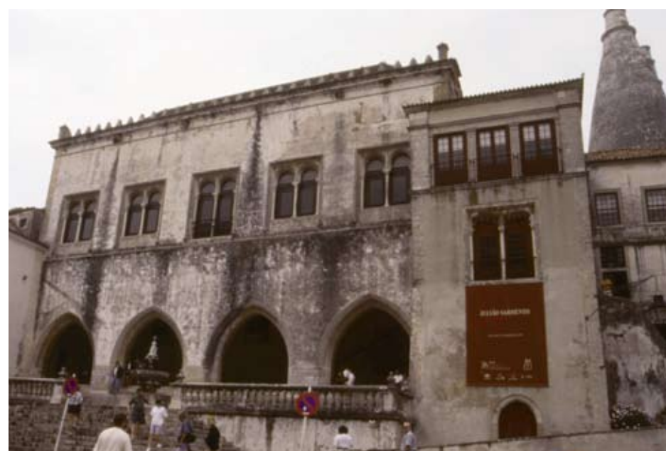
EL PALACIO NACIONAL DE SINTRA ES UN EDIFICIO TOTALMENTE REVOCADO. CON LOS AÑOS Y EL CLIMA HÚMEDO Y TEMPLADO DE SINTRA, LA COLONIZACIÓN BIOLÓGICA SE ARRAIGA CONTRIBUYENDO A SU DETERIORO QUE TAMBIÉN SE DEBE A LA POLUCIÓN AÉREA GENERADA POR EL TRÁFICO. VISTA DEL PALACIO ANTES DE LA INTERVENCIÓN (1995)
