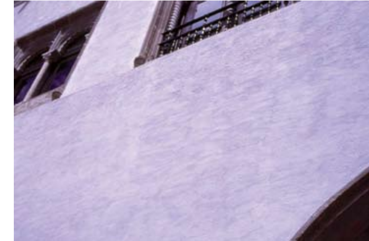
DETALLES DEL ASPECTO DE LAS PAREDES LUEGO DE LA INTERVENCIÓN.
