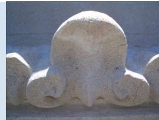
LA PÉRDIDA FUE REPUESTA. LO QUE CONSTITUYE UNA RESTAURACIÓN DEL DETALLE. ESTA REPARACIÓN ERA NECESARIA PARA EVITAR EL INGRESO DE AGUA EN LA PIEZAY EVITAR ASÍ UN MAYOR DETERIORO DE ESTOS ORNATOS DE SÍMIL-PIEDRA. (
