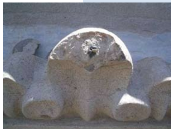
EJEMPLO DE RESTAURACIÓN CONSERVATIVE. CASO DEL TEATRO COLÓN, BUENOS AIRES. DETALLE DE UNA PÉRDIDA EN EL FRENTE DE UNA DE LAS DECORACIONES ARQUITECTÓNICAS. (FOTOS CORTESÍA DEL ARQ. M. MAGADÁN)
