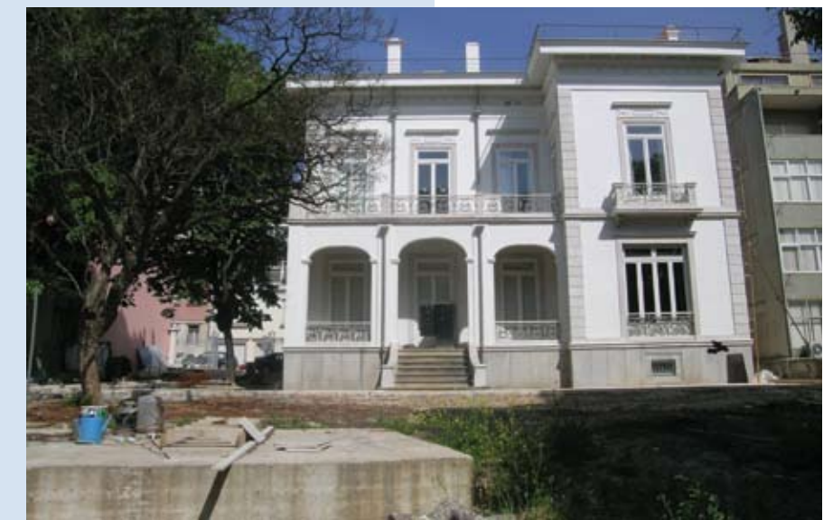
FUNDAMENTALMENTE, LA INTERVENCIÓN, DIVIDIÓ LA MANSIÓN EN DOS DEPARTAMENTOS Y SIRVIÓ PARA LA INSTALACIÓN DE SERVICIOS QUE NO EXISTIAN EN EL EDIFICIO ORIGINAL. MUCHAS VECES SE INTRODUCEN VARIACIONES EN SU APARIENCIA EXTERIOR, EN ESTE CASO SE AGREGÓ UNA BARANDA EN LA PARTE SUPERIOR DEL EDIFICIO REHABILITADO. TAMBIÉN SE QUITÓ UNA PARTE DEL TECHO DE TEJAS DEL EDIFICIO ORIGINAL PARA HACER UNA TERRAZA (DESPUÉS DE LA INTERVENCIÓN)
