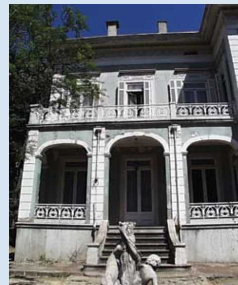
EJEMPLO DE "REHABILITACIÓN". LA REHABILITACIÓN, COMO LA MISMA PALABRA LO SUGIERE, ES UNA INTERVENCIÓN QUE VUELVE A "HABILITAR" UN EDIFICIO PARA SU USO. LAS FOTOS MUESTRAN UNA INTERVENCIÓN EN UN EDIFICIO PRIVADO, EL PALACIO ALMEIDA BRANDÃO EN LISBOA. (ANTES DE LA INTERVENCIÓN)
