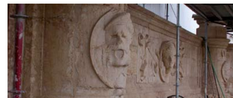
DETALLE DE UNO DE LOS MEDALLONES DE LA PLATIBANDA PLATERESCA QUE DECORA LA PARTE SUPERIOR DEL CLAUSTRO. SE PUEDEN OBSERVAR LA FALTA DE MORTEROS EN LAS JUNTAS (ALGUNOS YA REMOVIDOS POR SU AVANZADO ESTADO DE DETERIORO) Y UN "AGREGADO" EN LA BOCA DE LA FIGURA DONDE EXISTE UNA PÉRDIDA. ESTA PÉRDIDA NO FUE "COMPLETADA" PUES NO SE CONOCE EXACTAMENTE COMO ERA ORIGINALMENTE. ES DECIR, LA INTERVENCIÓN QUE SE REALIZÓ EN EL CLAUSTRO FUE EXCLUSIVAMENTE DE CONSERVACIÓN. LA SEGUNDA FIGURA ILUSTRADA, EN LA INTERVENCIÓN DEL CLAUSTRO SE TUVIERON QUE REPONER 15 KM DE JUNTAS QUE, O BIEN ESTABAN ABIERTAS, O PRESENTABAN LOS MORTEROS MUY DETERIORADOS.
