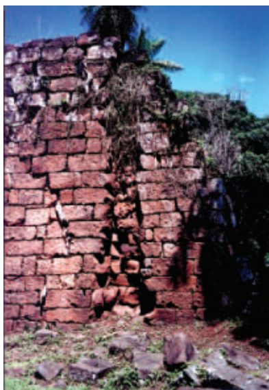
Fig. 9 (izq). Fracturas por incendio de columnas de madera en Santa Ana, Argentina.
