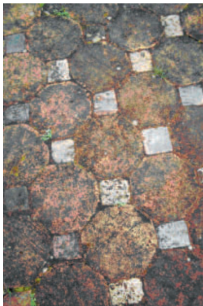
Fig. 15. Detalle de un piso cerámico en la Misión de la Santísima Trinidad, donde se utilizaron cerámicas comunes con cerámicas vidriadas azules.
