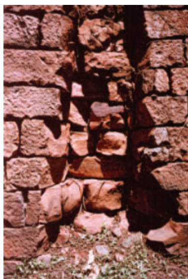
Fig. 9 (der). Detalle mostrando la fractura concoidal de los bloques de asperón.
