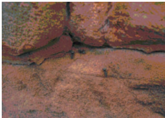
Figura 7. (b) Hormigas ingresando al interior de un muro a través de la separación entre los mampuestos y el mortero de junta. (Santísima Trinidad, Paraguay).
