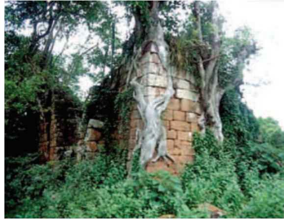
Figura 5. (b). Arbol creciendo sobre una estructura original.
