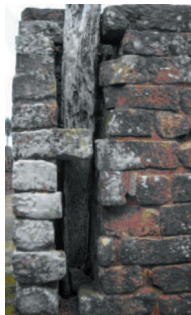
Fig. 12 - Columna esquinera perteneciente a una de las "casas de indios". Santísima Trinidad, Paraguay. Coluna do cunhal de uma das "casa de indios". Santísima Trinidad, Paraguai.
