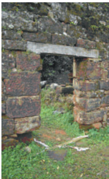
Fig. 10 - Dintel de la restauración realizada por el Arqto. Carlos Onetto entre 1940 y 1948. San Ignacio Miní, Argentina. Verga da restauração realizada pelo Arq. Carlos Onetto nos anos 1940 e 1948. San Ignacio Miní, Argentina.
