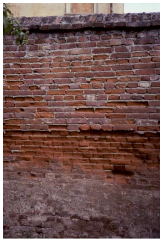
PARED EN LA QUE EL MORTERO ORIGINAL DE CAL FUE REEMPLAZADO POR UNO DE CEMENTO PÓRTLAND. COMO ESTOS MORTEROS SON MENOS POROSOS QUE LOS LADRILLOS ORIGINALES DE LA PARED, LA CRISTALIZACIÓN DE LAS SALES QUE PENEIRAN EN ELLA POR CAPILARIDAD, CRISTALIZAN EN LOS LADRILLOS DETERIORÁNDOLOS.
