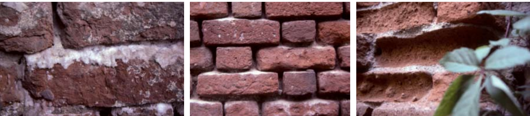
DETALLE DE LA CRISTALIZACIÓN DE LAS SALES SOLUBLES QUE DETERIORAN EL MORTERO DE CAL AÉREA, PUES AL SER MÁS POROSO, LA EVAPORACIÓN DEL AGUA Y LA CONSECUENTE CRISTALIZACIÓN DE LAS SALES OCURRE EN ESE MATERIAL.
