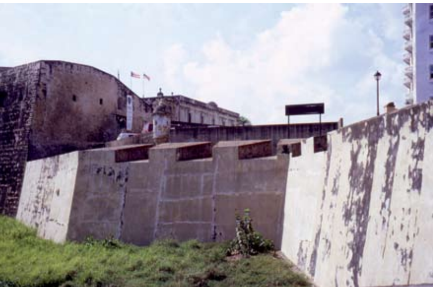
DETALLE DE LOS PRIMEROS PANELES DE REVOQUE A BASE DE MORTEROS DE CAL CON PROBLEMAS RESULTANTES DE UNA POBRE APLICACIÓN.
