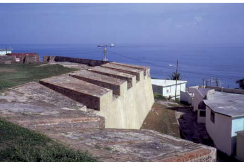
CON LA PRÁCTICA, SE LOGRÓ OBTENER UN EXCELENTE RESULTADO EN LA APLICACIÓN DE LOS REVOQUES A BASE DE MORTEROS DE CAL, QUE NO INDUCEN DETERIORO EN LA MAMPOSTERÍA ANTIGUA.
