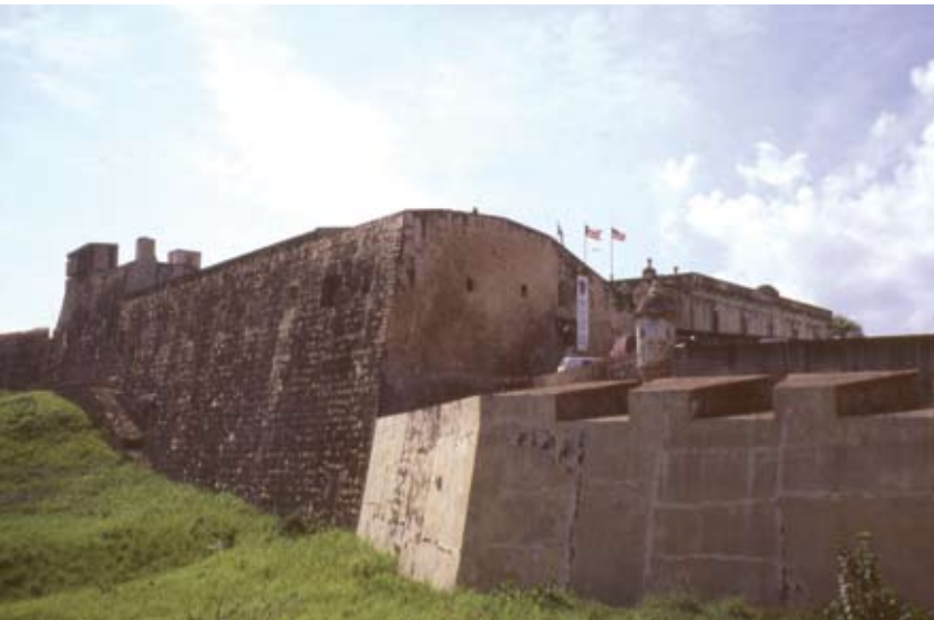
MURALLAS DE SAN JUAN DE PUERTO RICO. COMO LOS REVOQUES DE MORTEROS DE CEMENTO PÓRTLAND INDUCÍAN DETERIORO EN LAS MURALLAS, SE COMENZARON A UTILIZAR REVOQUES DE MORTEROS DE CAL. PARA CUYA APLICACIÓN SE REQUIERE MÁS EXPERIENCIA.
