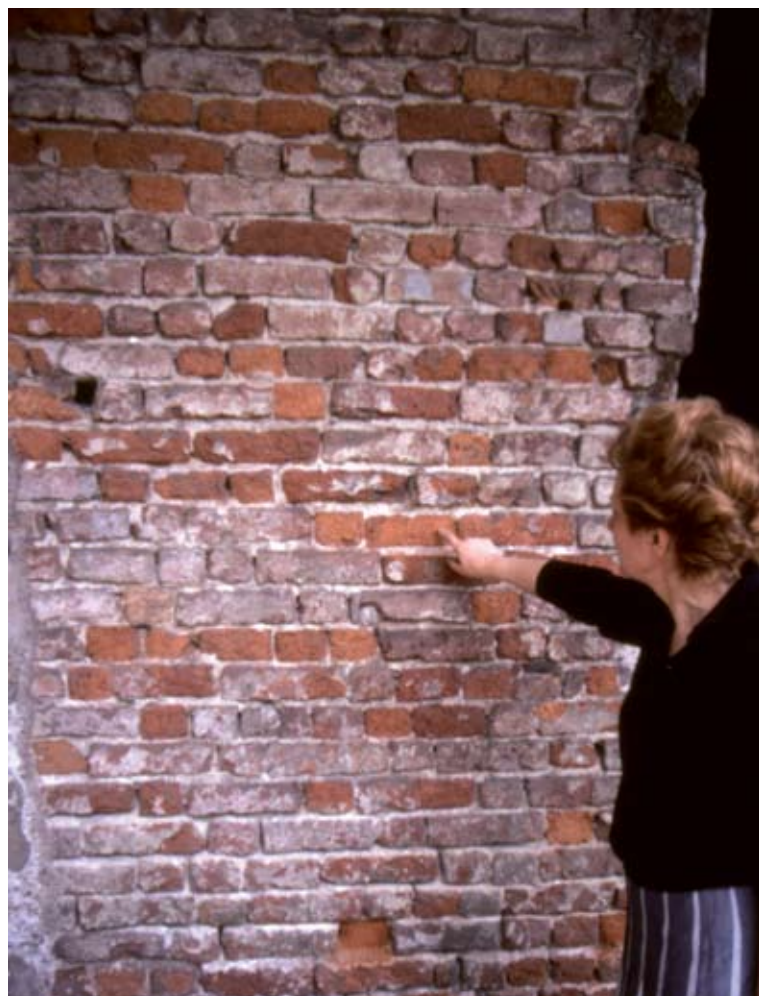
LA PROF. LUIGIA BINDA DEL POLITÉCNICO DE MILANO SEÑALA LA ALTURA HASTA LA CUAL LLEGA EL ASCENSO CAPILAR EN UNA PARED DEL CLAUSTRO DE SAN EUSTORGIO EN MILAN (ITALIA). EL CLAUSTRO FUE UTILIZADO COMO CABALLERIZA EN SIGLOS PASADOS, LO QUE GENERÓ SALES SOLUBLES QUE ESTÁN DEGRADANDO LOS MATERIALES.
