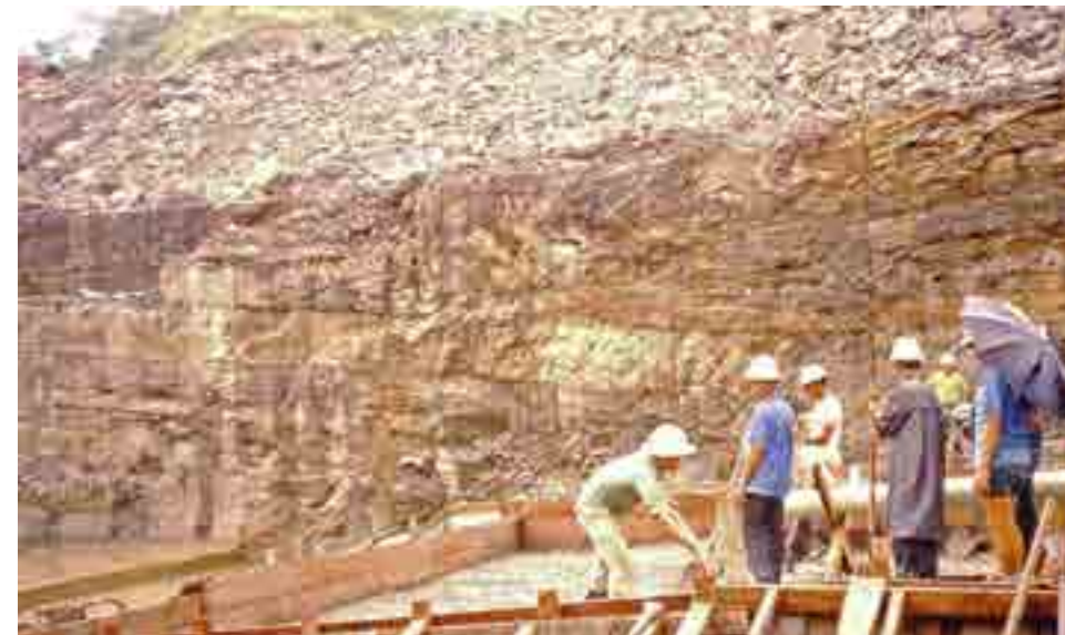
Trabajadores en plena faena dura la construcción de la represa de Bayano, circa 1971. Bayano es el mayor curso del oriente de la provincia de Panamá y habitado por cuatro siglos por el pueblo Kuna. La construyó la empresa yugoslava Energoprojekt, 1969-1973. Foto, R. Stewart. Cortesía, Douglas Allen y Grettel Villalaz de Allen.
