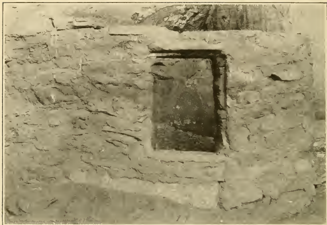
a. DOORWAY IN RUIN 6
