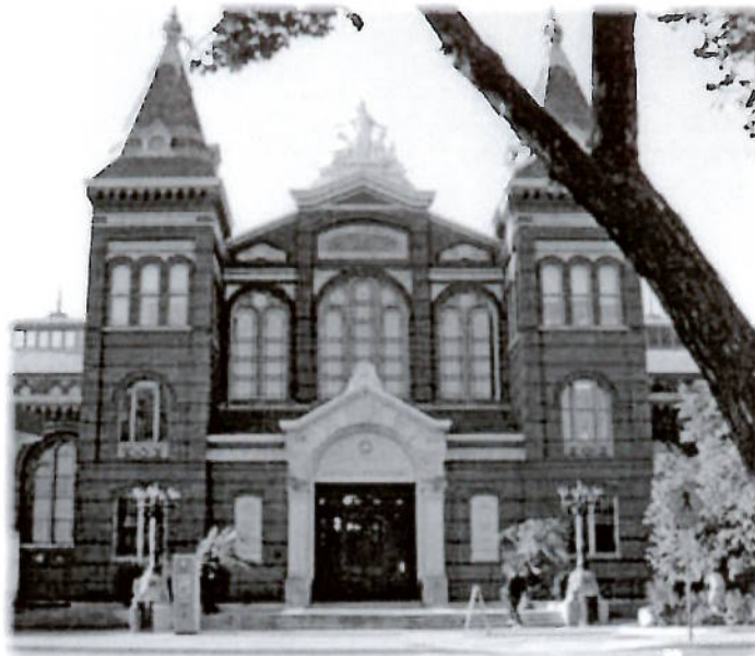
Рисунок 6. Северный вход Дома произведений искусства и промышленности. Это было первое здание, построенное для экспонирования коллекции Смитсоновского института
