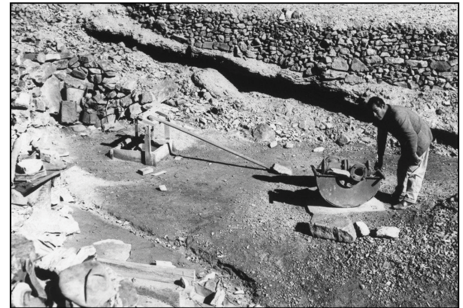
Curioso y rudimentario aparato manual llamado kimbelete para trabajar mineral en una mina en Tasna, altiplano boliviano. Refleja la rudimentaria tecnología del sector minero boliviano en la década de 1960. Foto, R. H. Stewart, 1966. Cortesía, Douglas Allen y Grettel Villalaz de Allen.
