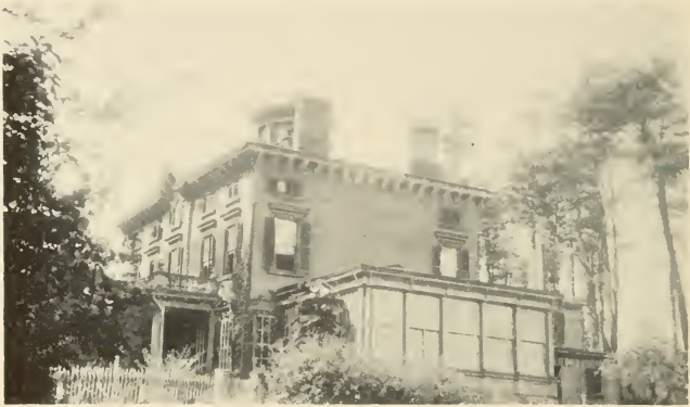
FIG. 61.—Canfield house at Dover, N. J.
